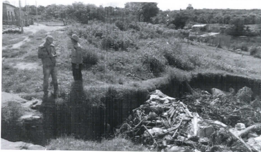
Travessa Raimunda Antonieta Canto com Rua 25 de Dezembro – Foto 05
