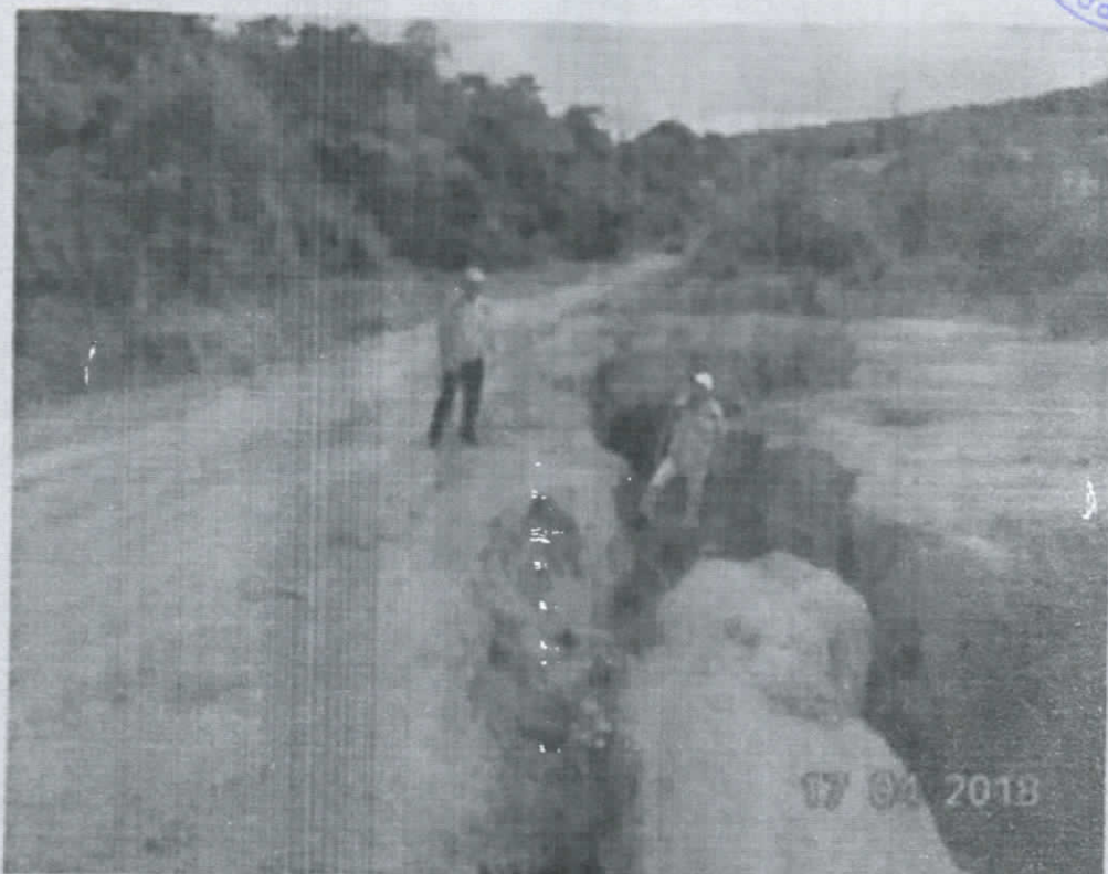
Ladeira Vicinal Comunidade Curumu GPS (51°49'03.7"W 55°36'46.2") Foto 17
